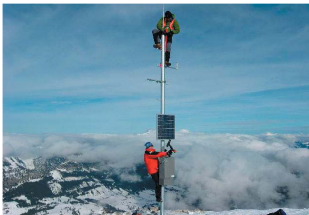
Schließlich konnte die Station wieder aufgestellt werden. Foto: LWD
