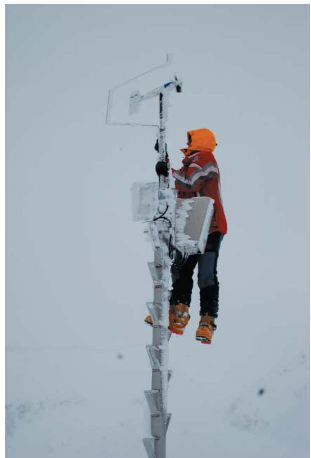
Reperatur- bzw. Wartungsarbeiten auf dem Kleinen Rotbühel. Foto: LWD
