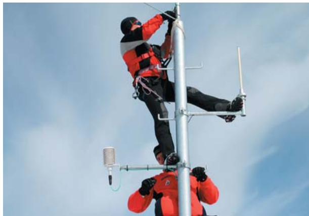
Reparaturarbeiten an der Station Mullerreck. Foto: LWD
