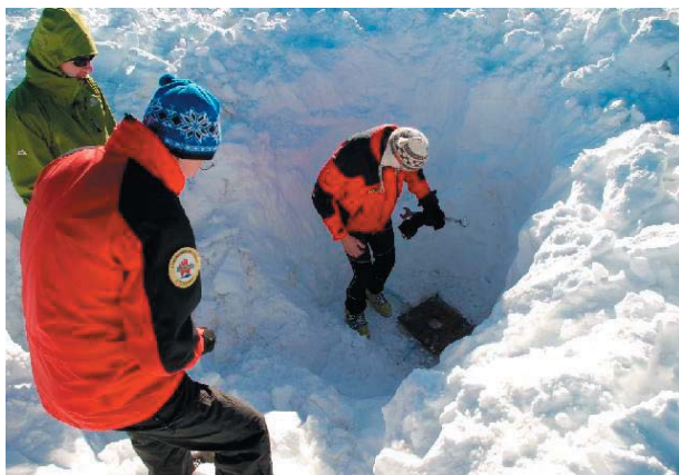
Nach langem Schaufeln kam endlich das Betonfundament zum Vorschein. Foto: LWD
