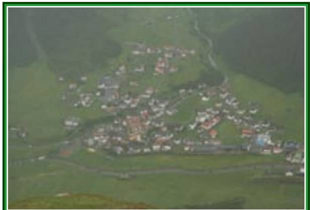
Blick vom Anrissgebiet auf die Lawinenverbauung von Galtür. Foto: LWD Tirol
