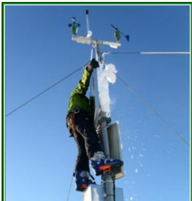
Neben den Enteisungsarbeiten wurde an der meteorologischen Messstation Ebenstein auch die Batterie getauscht. Foto: LWD
