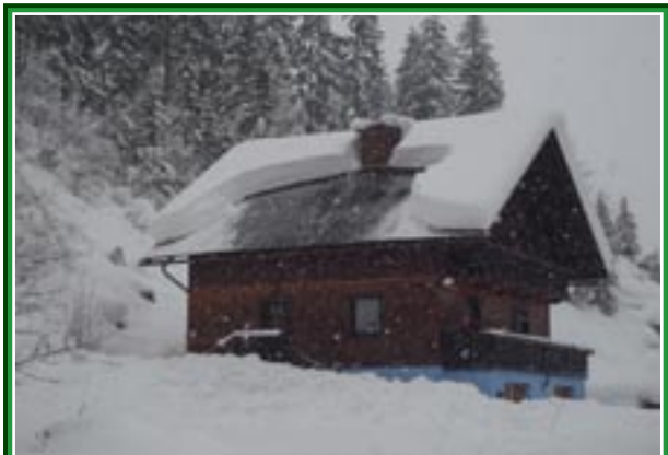
...Dachlawinen beobachtet werden. Foto: H. Kain
