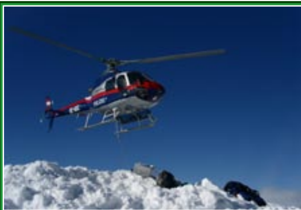
Mit dem Hubschrauber wurde ein stärker dimensionierter Mast auf die Hohe Veitsch geflogen... Foto: LWD
