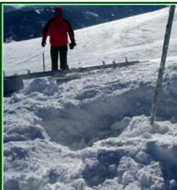
...und im Anschluss der gesamte Mast vom Betonfundament getrennt. Foto: LWD
