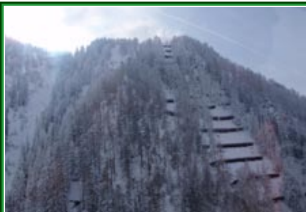
Die Lawinenverbauungen hatten noch Aufnahmepotential, aufgenom- men am 18.02.2009. Foto: LWD
