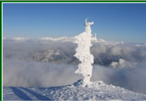
So präsentierte sich die Station unmittelbar nach der Ankunft: Mächtige Eisformationen machten einen ordnungsgemäßen Betrieb der meteorologischen Station am Multereck unmöglich. Foto: LWD
