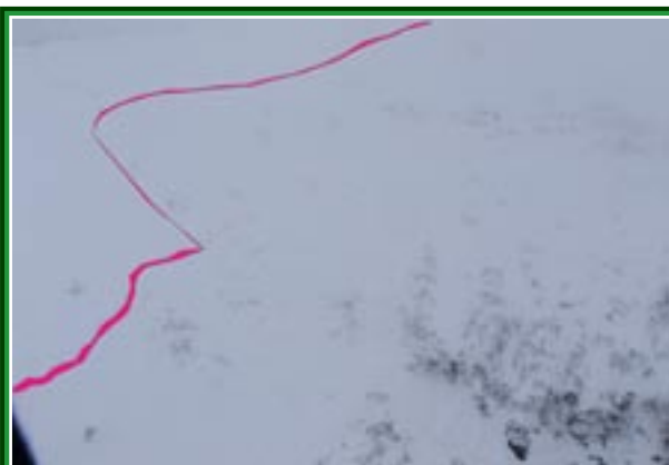
Die Höhe des Anrisses lag zwischen 2 m und 4 m. Foto: LWD
