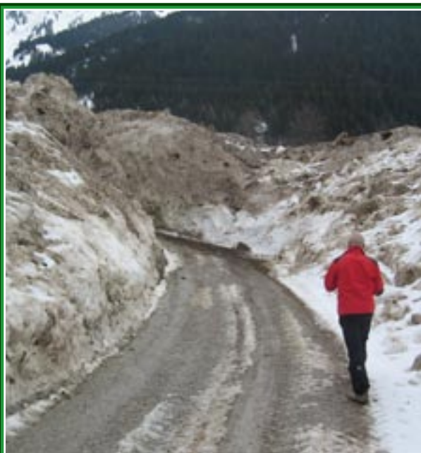
Im Bild ist eine von den Schneemassen wieder befreite Seitenstraße zu sehen. Foto: LWD
