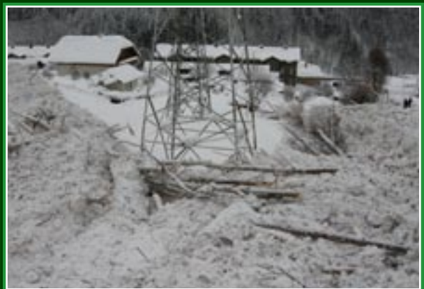
Ein 110-kV-Hochspannungsmast wurde durch die Lawine beschädigt. Foto: J. Vaczulik
