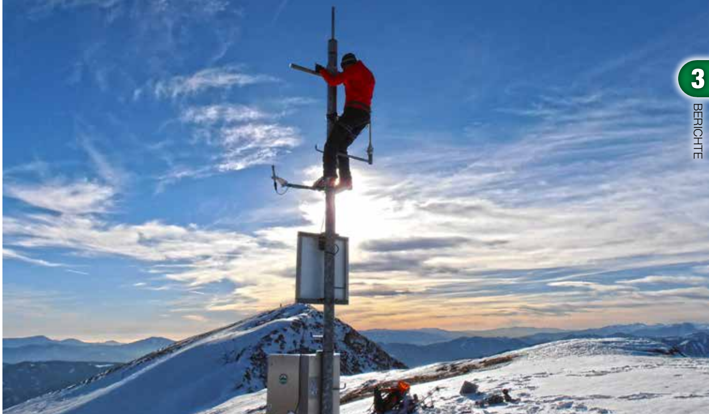
34 Reparaturarbeiten (Windmessung und Temperaturfühler) auf der Hohen Veitsch. (Foto: LWD) |
