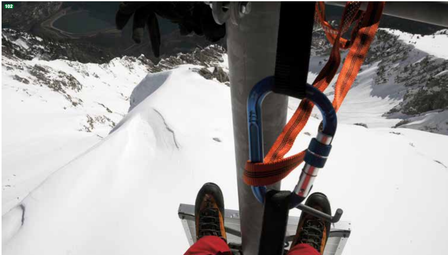
102 Die Sicherung während der Stationswartungsarbeiten ist nicht einfach, da man die meiste Zeit an der Mastspitze arbeitet und beide Hände für die Montagearbeiten benötigt. (Foto: LWD) |
