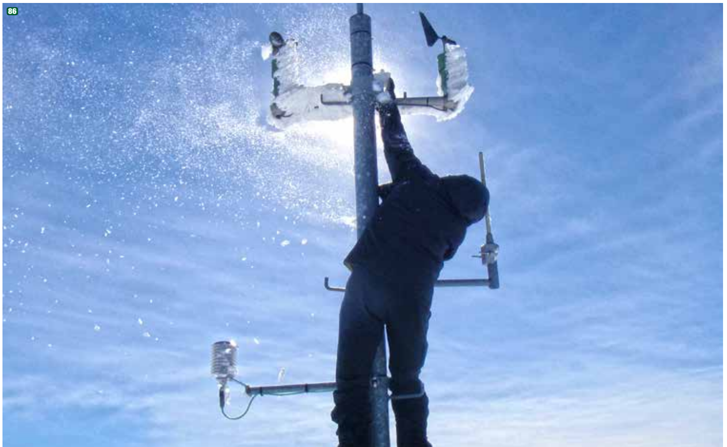
86 Enteisungsarbeiten auf der Hohen Veitsch. (Foto: LWD) |
