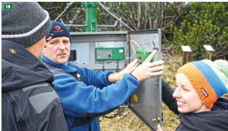
19, 20 Mitarbeiter von Wiener Wasser und LWD Steiermark bei den Aufbauarbeiten. (Foto: LWD Steiermark) |
