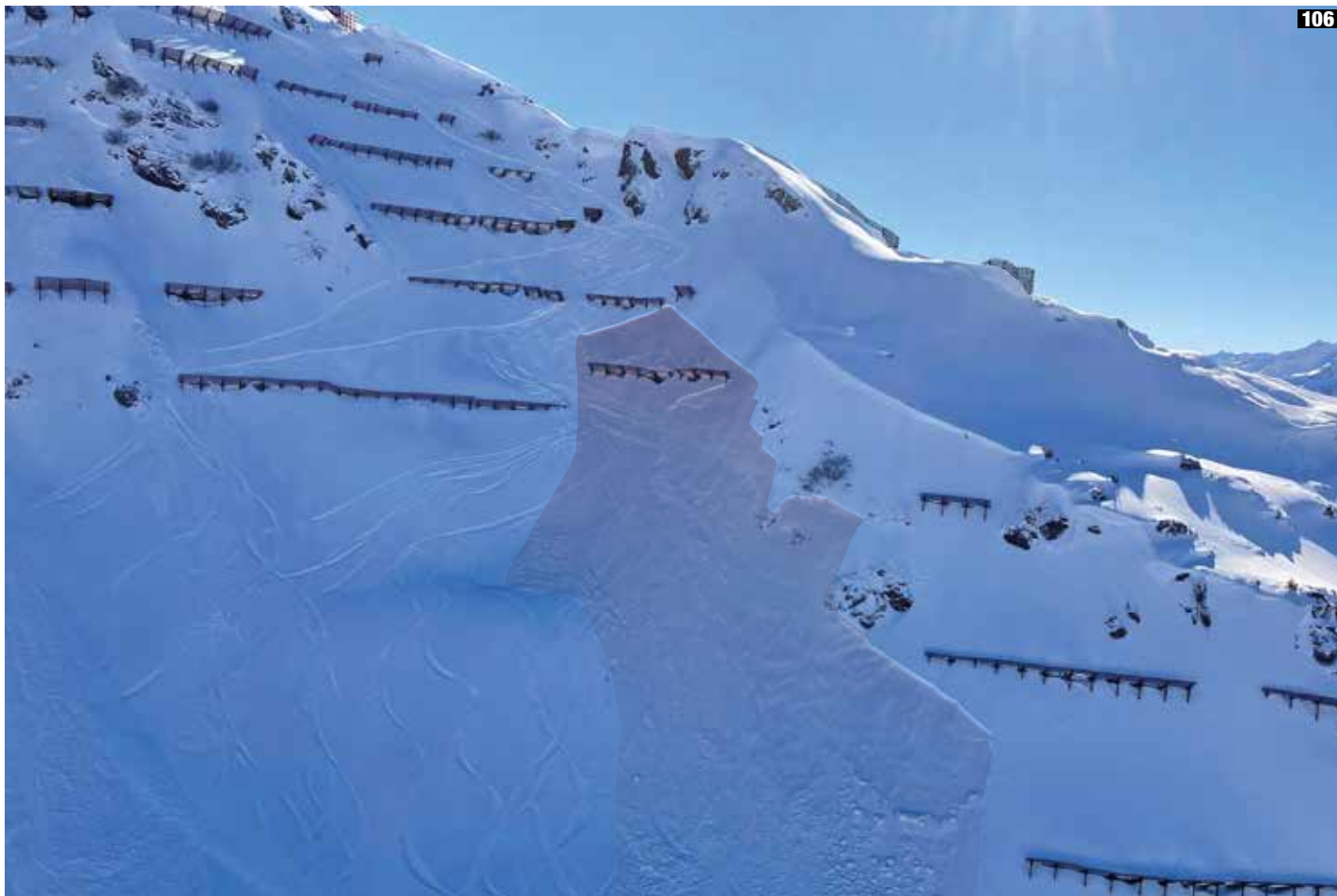
106 Übersicht des Unfallgeländes im Bereich der Lawinenverbauungen. (Foto: Alpinpolizei, 23.02.2022) |
